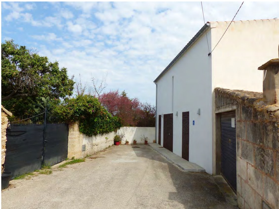
5. Al fons del carreró, la paret que limita amb el sòl rústic. Cap a la dreta, dues edificacions
