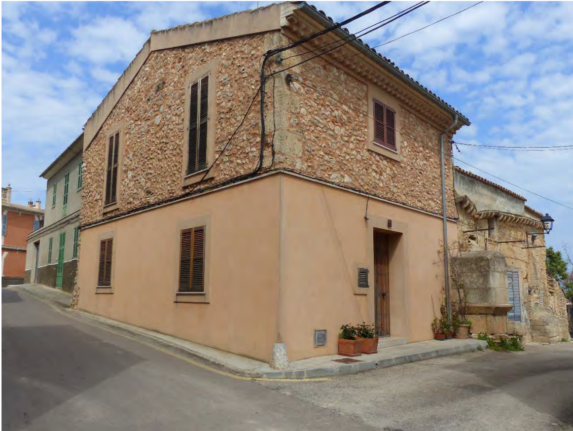
2. Edificació a la banda N del carreró, cantonada amb el c/ Roca Llisa
