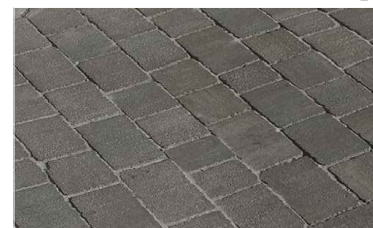
Paviment àmbit per a vehicles
