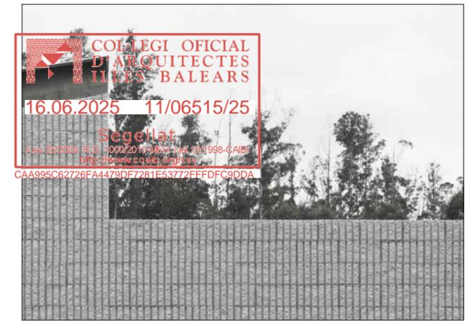
Textura y despiece muro de fabrica portante
