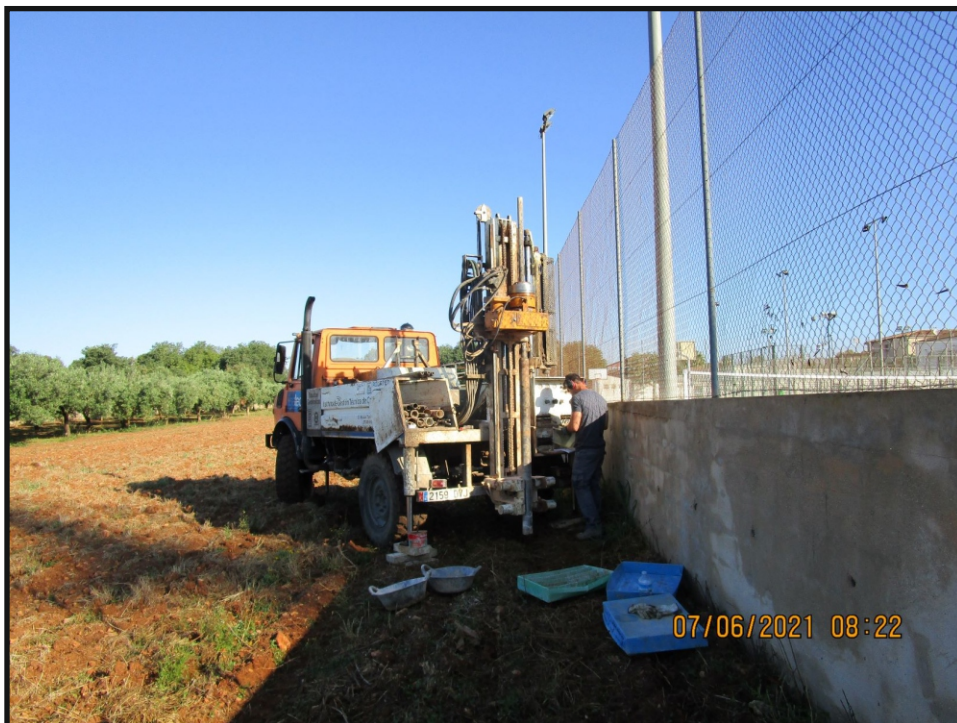
Foto 6: Detalle de la realización del sondeo S-3. .
