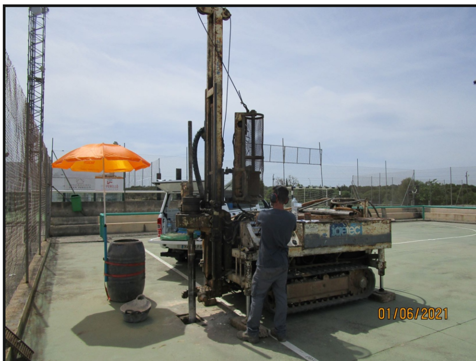
Foto 5: Detalle de la realización del sondeos S-2
