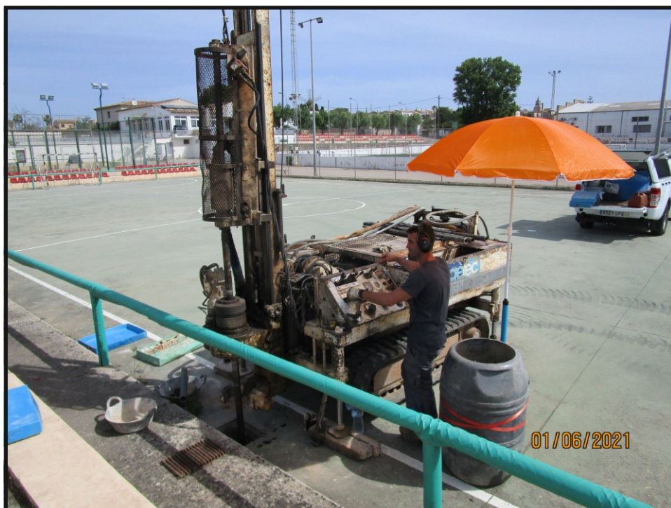
Foto 4: Detalle de la realización del sondeo S-1
