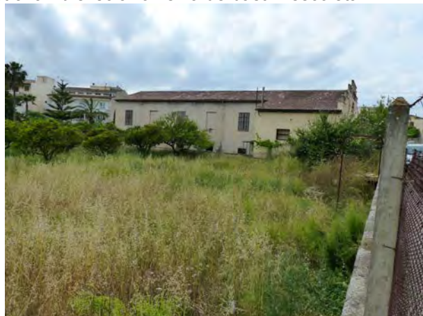
11. Vista de la façana lateral de l'edifici veïnat, de Pep Perelló Construccions, que es troba dins la mateixa parcel·la cadastral, i respecte del qual s'haurà de fixar una separació
