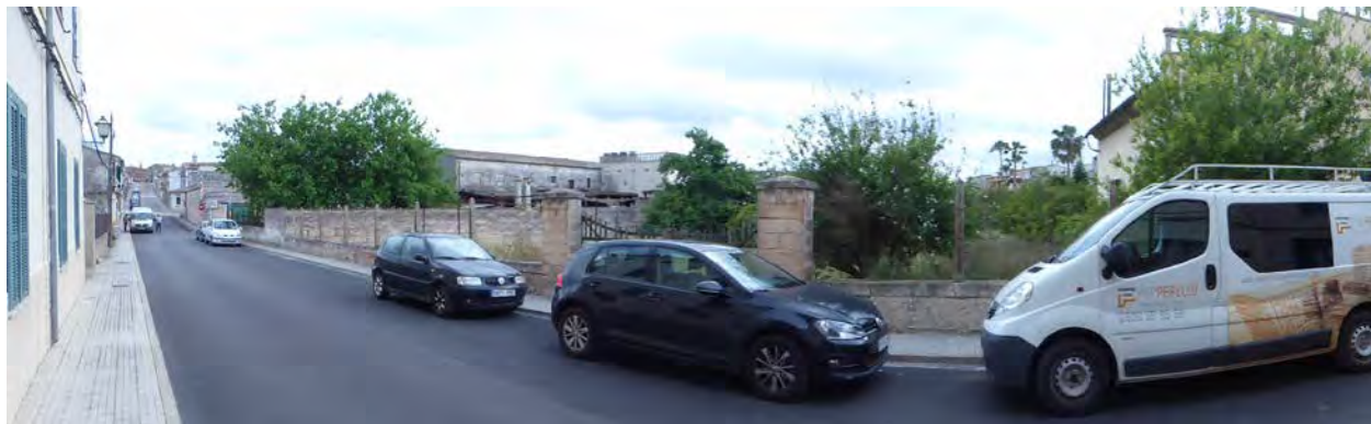
7. Vista de la façana del solar des del seu extrem nord
