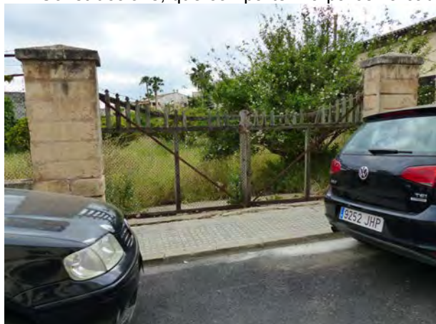
10. Vista del portal d'entrada al solar
