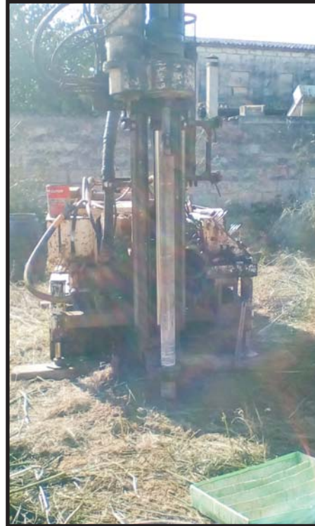
Foto 3: Detalle de la realización del sondeo S-1.
