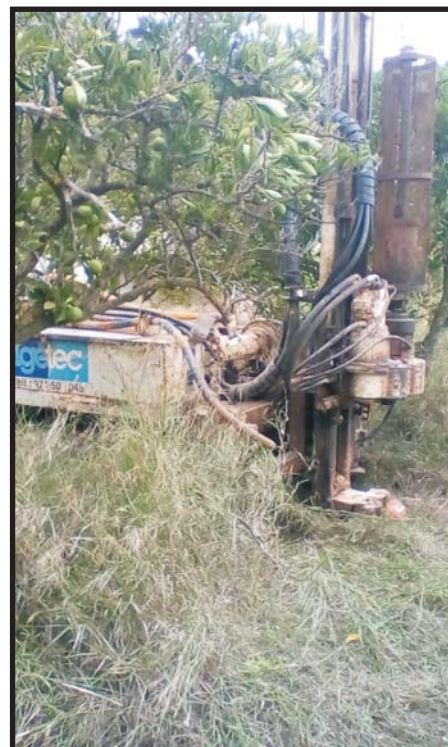
Foto 6: Detalle de la realización del ensayo penetrométrico P-2.
