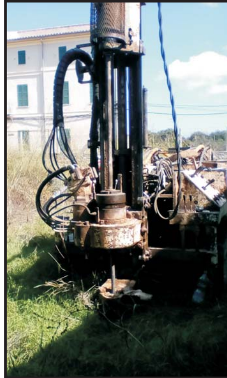
Foto 5: Detalle de la realización del ensayo penetrométrico P-1.
